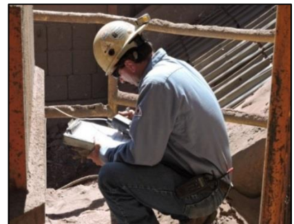
Fig. 35 Toma de lecturas del monitor antes de la entrada
