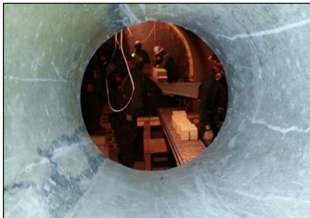
Fig. 1 Colocación de ladrillos en un espacio confinado
