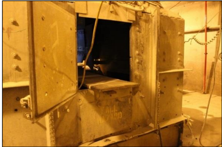
Fig. 3 La chimenea de una trituradora es lo suficientemente grande para entrar
