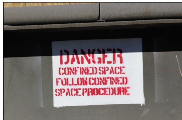
Fig. 36 Carteles de espacio confinado
