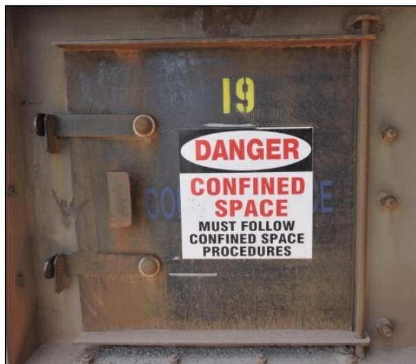
Fig. 31 El cartel en la entrada de una chimenea es un control administrativo
