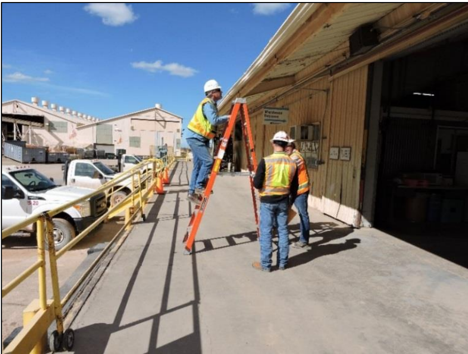
Peligro(s) de caídas
