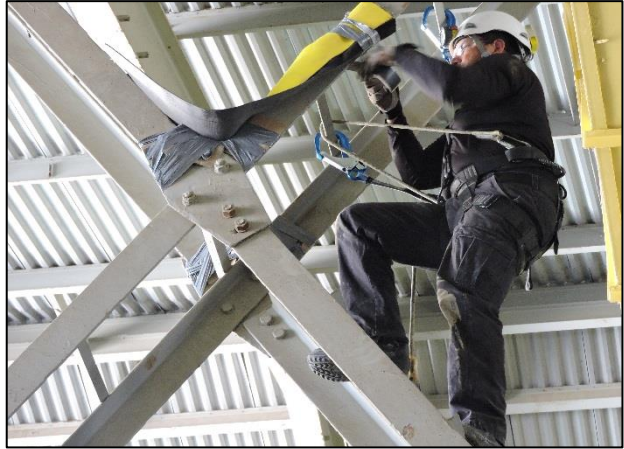
Fig. 44 Uso de un sistema de posicionamiento contra caídas
