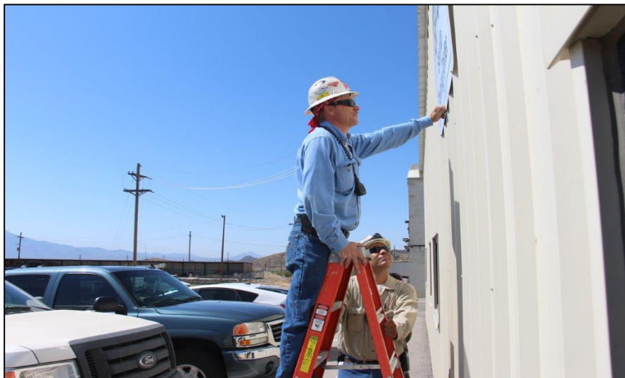
Fig. 52 Trabajar de forma segura en una escalera
