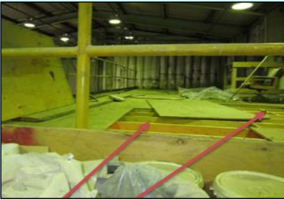
Fig. 1 Piso del entrepiso donde se retiró la madera enchapada sobre el cielo raso falso
