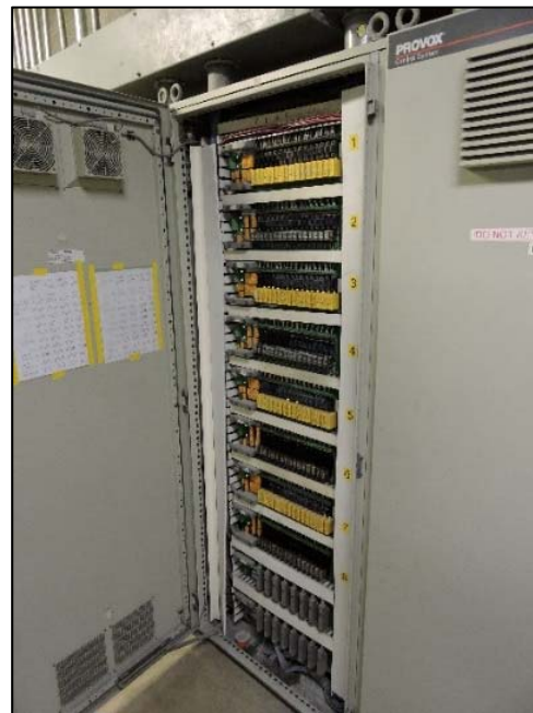
Fig. 25 Labeling on the door
