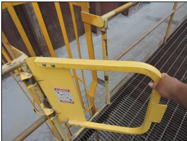
*Fig. 2.6 Las puertas oscilan hacia el empleado cuando la transición es hacia un nivel inferior*
