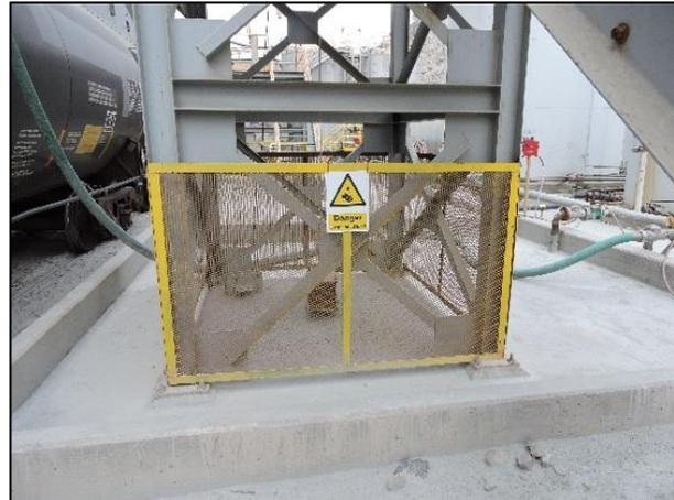
Fig. 2.3 La barrera permanente restringe el acceso a una carga suspendida
