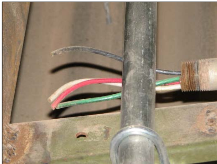
Fig. 3.10 Conductores rotos en un conducto.
