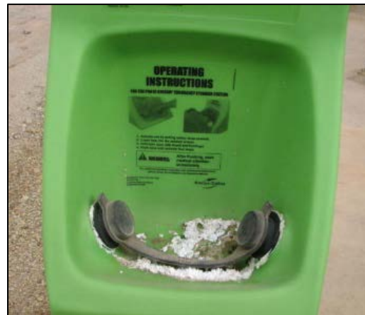
Fig. 3.25 Estación de lavado de ojos con acumulación de suciedad.
