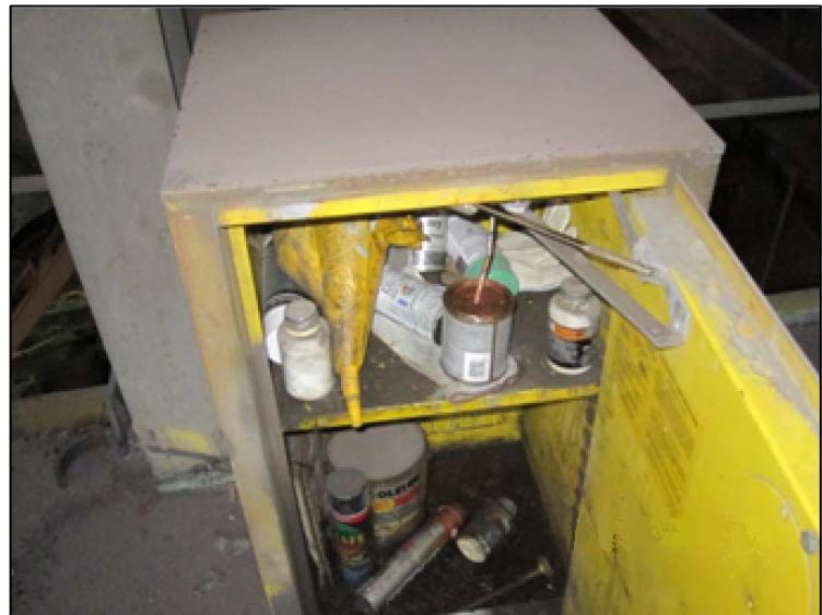
Fig. 3.23 Materiales almacenados inadecuadamente.
