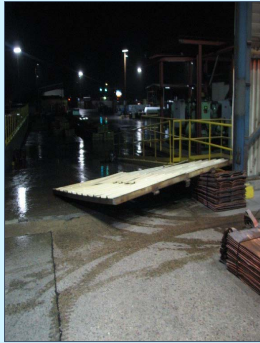
Fig. 2.6 Otro ángulo de la puerta caída.
