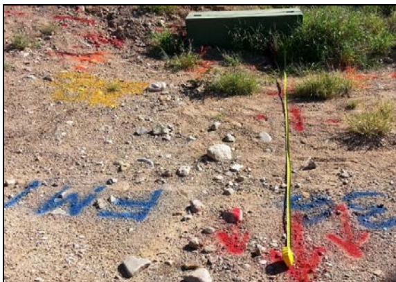
Fig. 3.32 Marcadores de estacas azules en un área de trabajo.
