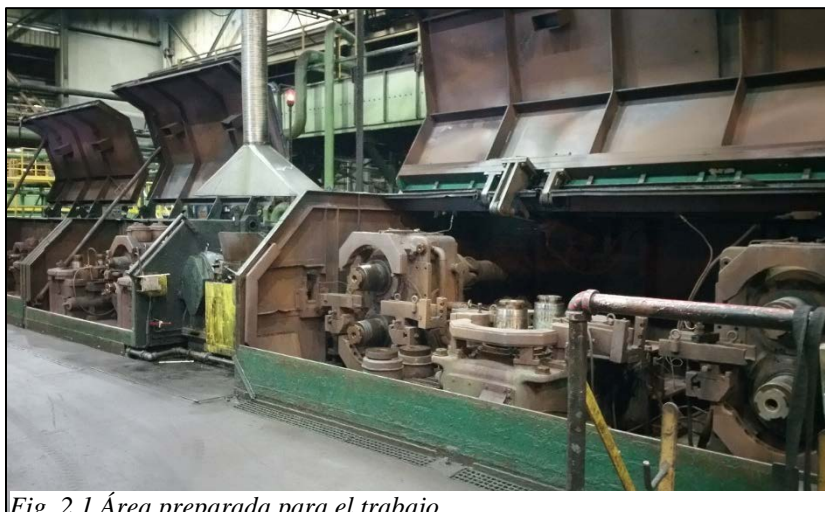
Fig. 2.1 Área preparada para el trabajo.
