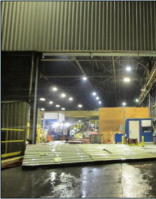
Fig. 2.5 La puerta que se cayó.
